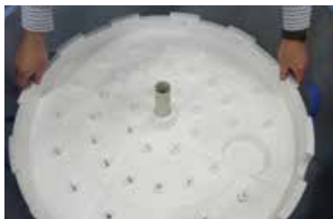
Ylimmän vedenjakolevyn asentaminen
