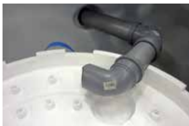
Vesilukko voidaan ottaa pois käytöstä poistamalla putken kulma tai kääntämällä se kuvan tavalla sivulle.
